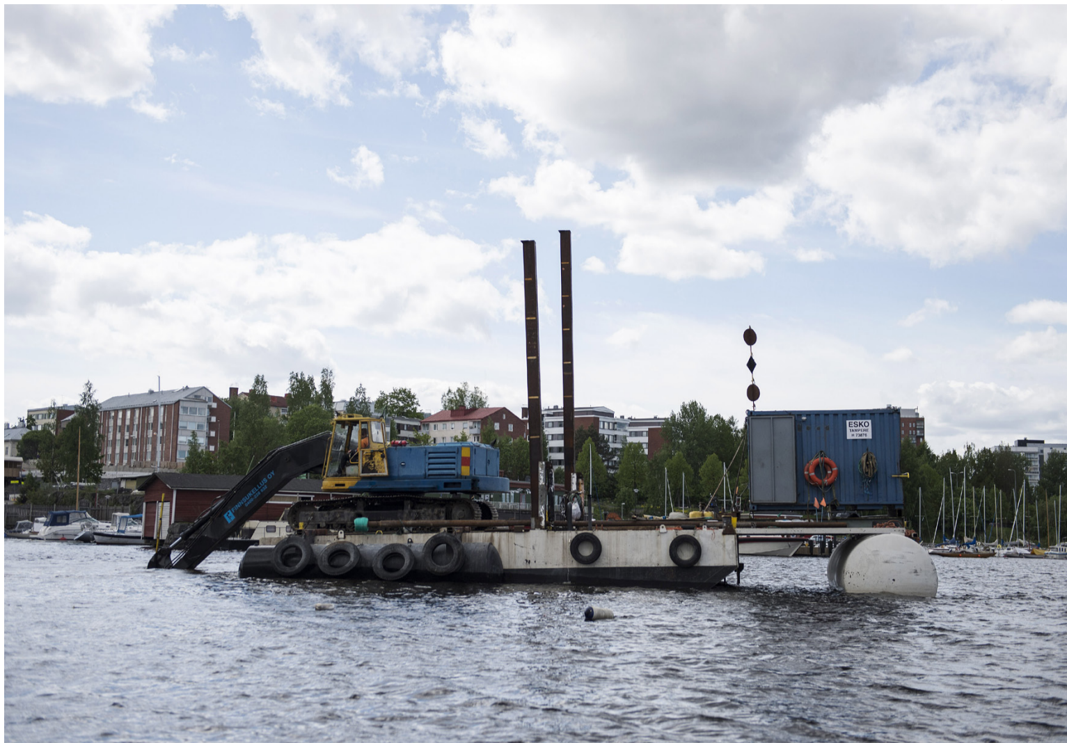
NAISTENLAHDESSA ruopataan satama-altaan pohjaa järveen laskettavaa uutta maakaasuputkea varten. Räjätystyöt on juuri saatu päätökseen. Maakaasuputken ensimmäistä osaa päästään uittamaan paikalleen ensi viikon lopulla tai sitä seuraavalla viikolla.
